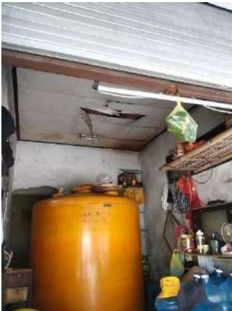
Tangki di gunakan untuk menyimpan air baku sebelum diproses lebih lanjut di banjar pitik.
