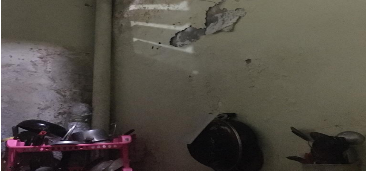
Keadaan dapur salah satu rumah di Desa Tegal Haum
