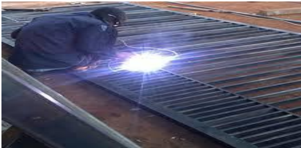
Dokumentasi pada saat pekerja melakukan pengelasan .
