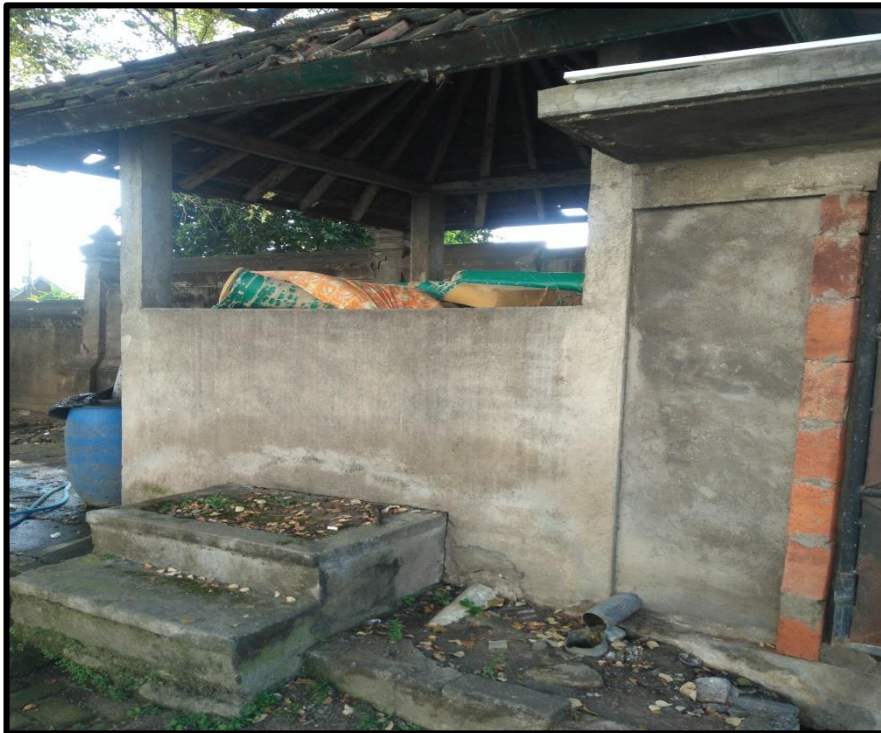
Tembok Bangunan TPS Limbah Medis
