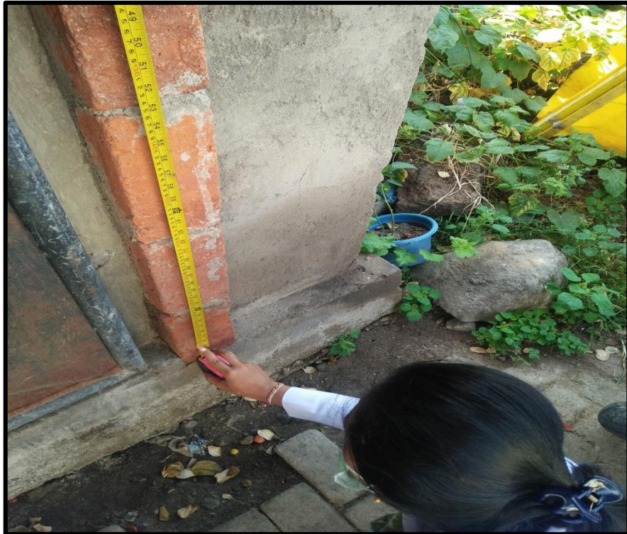
Pengukuran Tinggi Bangunan TPS Limbah Medis
