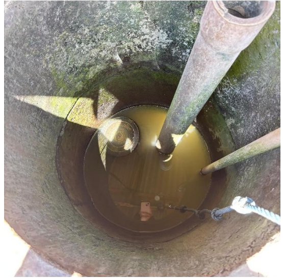
Sarana konstruksi sumur gali
