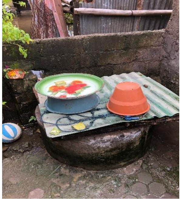
Penutup sumur yang tidak memenuhi syarat
