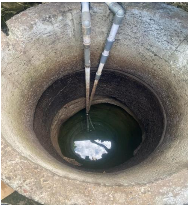
Konstruksi Fisik Sumur Gali
