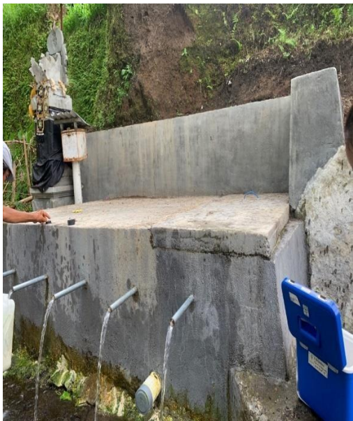
Kondisi konstruksi Perlindungan Mata Air Jepun Setelah diperbaiki
