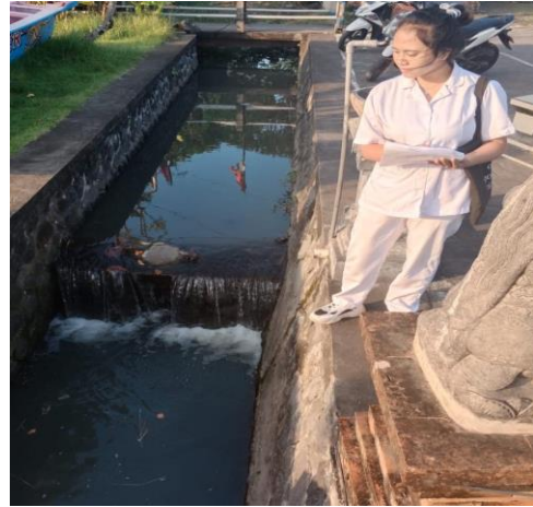
Pemeriksaan fasilitas sanitasi terkait pembuangan air limbah pada pantai Yeh Gangga
