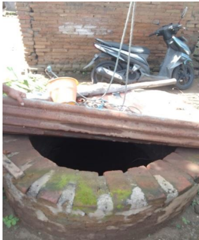
Keadaan bibir sumur gali yang tidak diplester menggunakan semen
