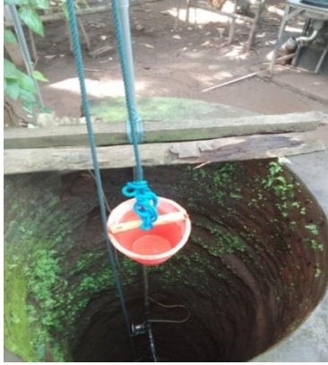
Kondisi fisik dinding sumur gali Desa Anturan
